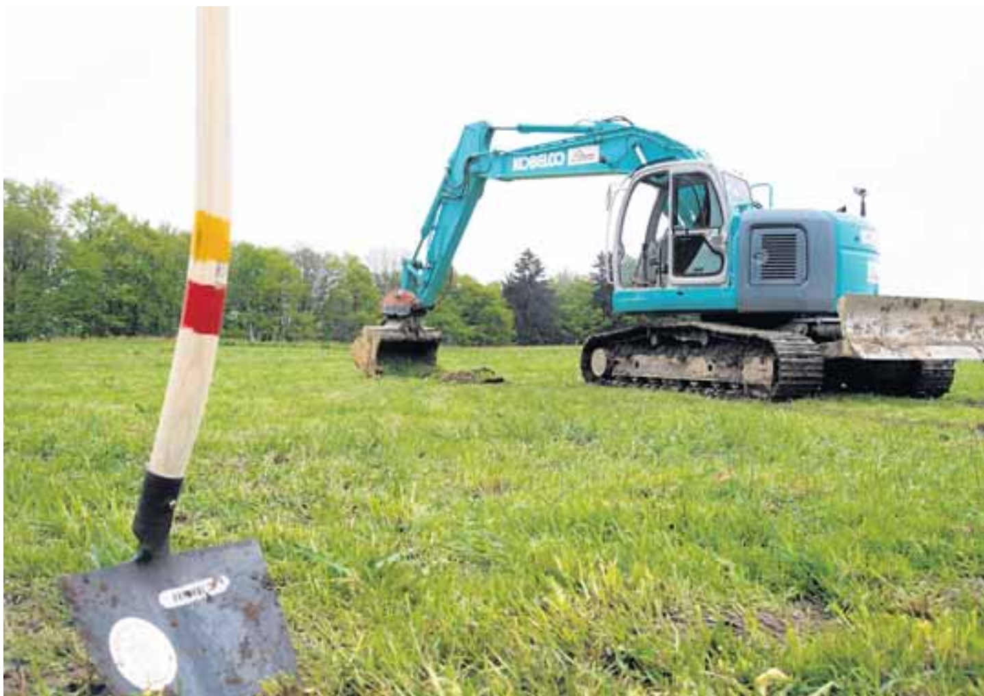
Auf einem Terrain von 15 000 Quadratmetern entstehen eine neue Käserei und ein Käsereifungslager.
